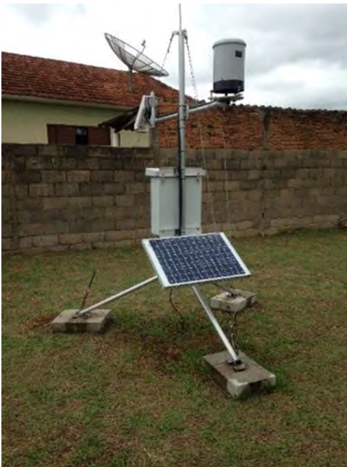
Vista geral da estação EFM (após limpeza)
