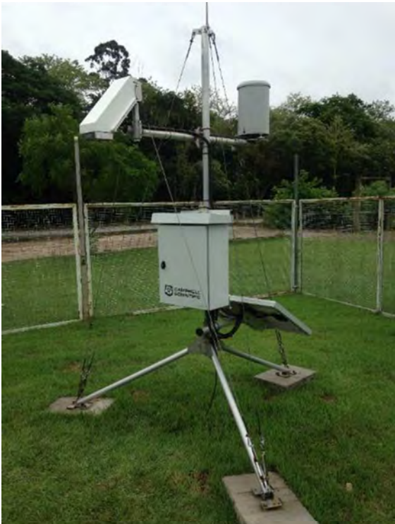
Vista geral da estação EFM (após limpeza)
