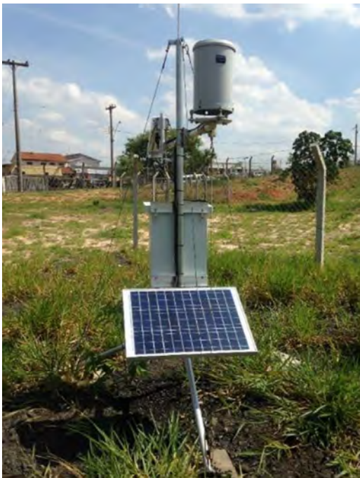
Vista da estação EFM mostrando vegetação alta
