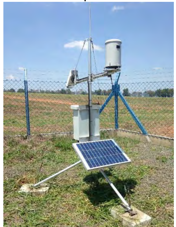
Vista geral da estação EFM (após limpeza)
