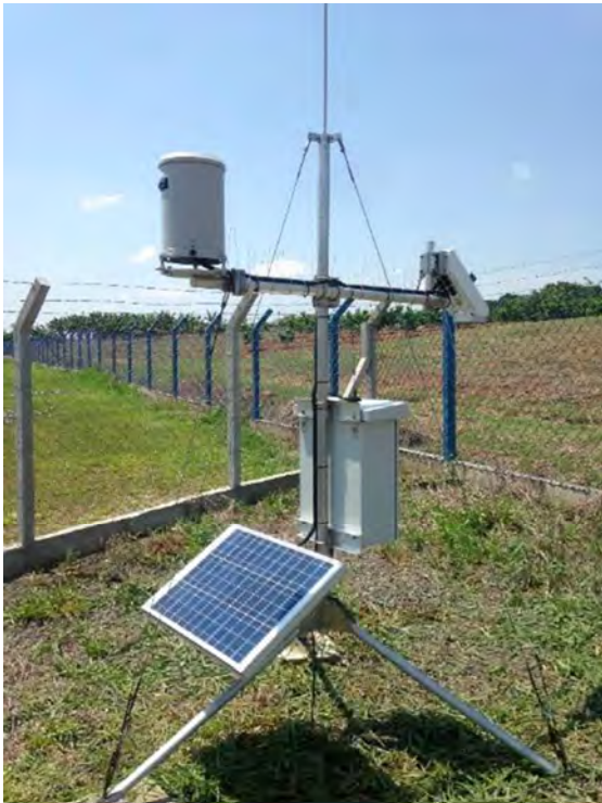
Vista geral da estação EFM (após limpeza)
