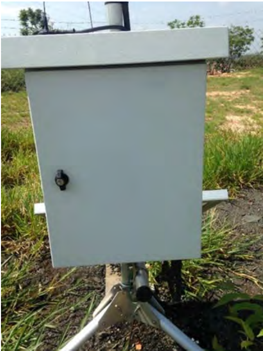
Vista da caixa de acondicionamento (após limpeza)
